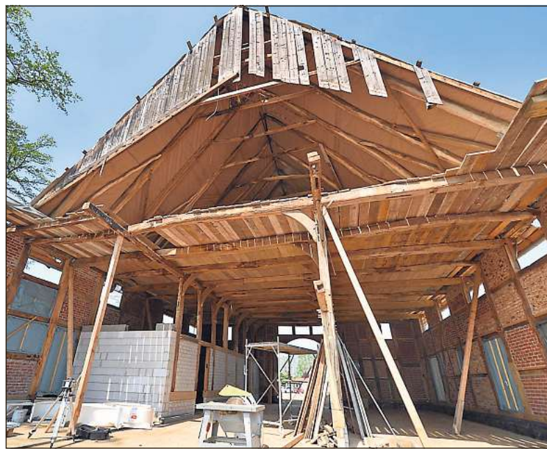
Besondere Herausforderung: Der Dielencharakter des denkmalgeschützten Gebäudes soll erhalten bleiben.
