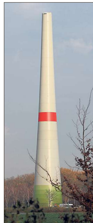
An diesen Anlagen scheiden sich die Geister. Bild: Sudbrock
