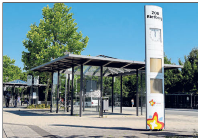
Die Uhr am ZOB in Rietberg ist defekt. Sie zeigt seit Wochen die identische Zeit. Eine Reparatur ist angekündigt. Foto: Stefan Lind
